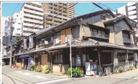
기존 목조 건물 개조 사례(공방·카페)
