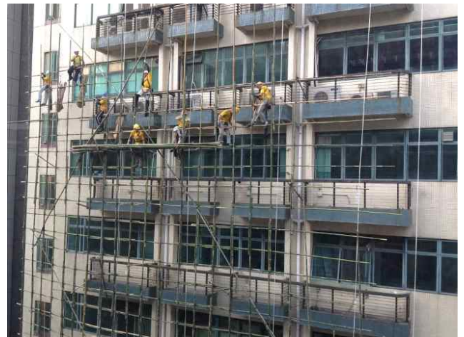
인터넷 사진 참조(홍콩 건축현장의 대나무비계)
